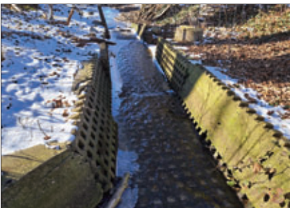
Ein mit Rasengittersteinen verbautes Gewässer. Die Platten sind instabil und im Hintergrund kann man sehen, wie sie bereits ins Gewässer fallen. Zurück bleibt ein ungeschütztes Ufer.
